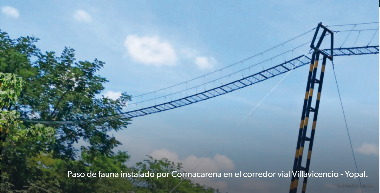
Paso de fauna instalado por Covioriente en el corredor vial Villavicencio - Yopal.
