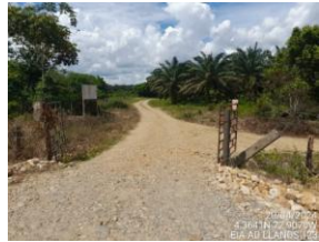
V35. Vía Hijoja - Campamento Brisas
