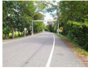
V4. Vía Central del Llano
