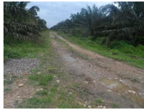
V95. Vía interna 3 Sector Guadualito
