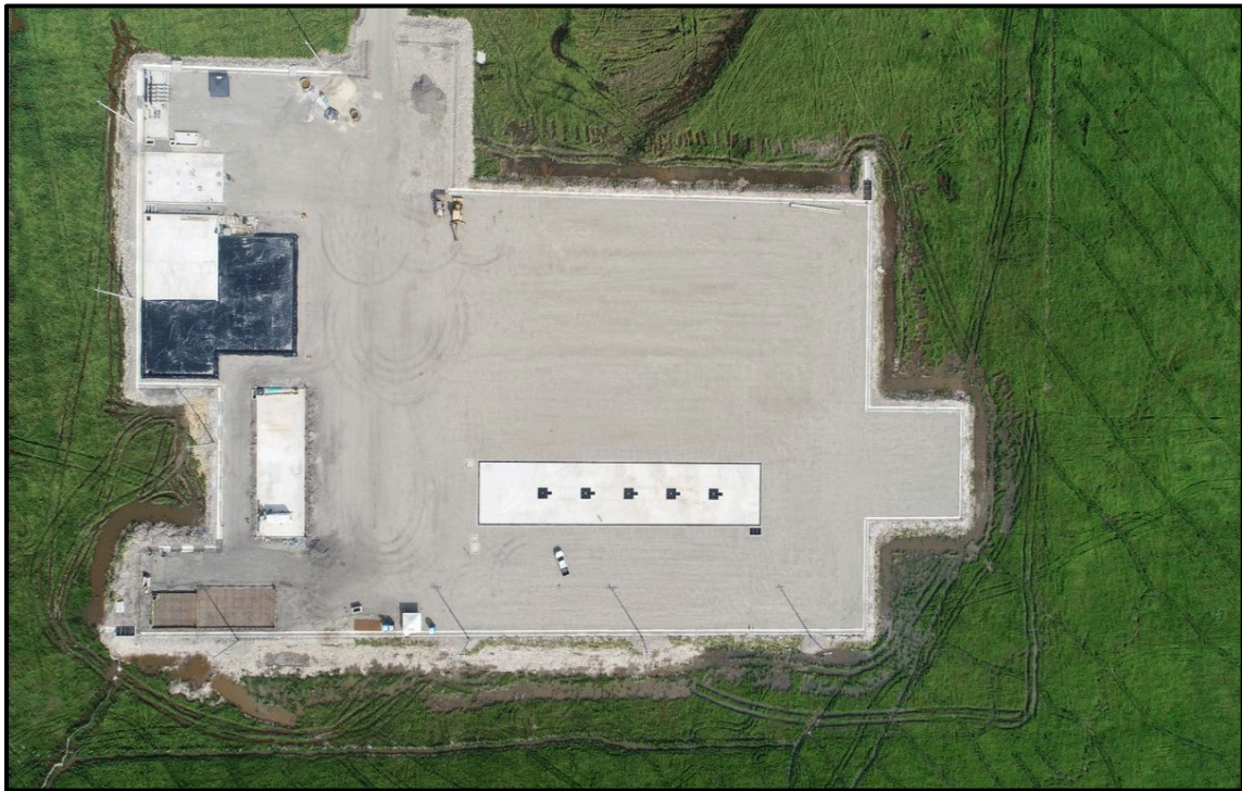
Fotografía No 266. Panorámica aérea de la locación Tigui Sur Este
