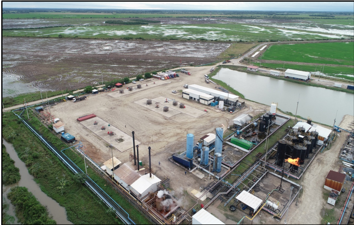
Fotografía No. 6. Vista aérea de la locación Jacana
